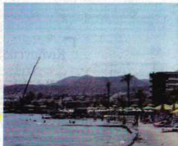
Η Κερσατόκρητος είναι χαρακτηριστική περίπτωση όπου, σύμφωνα με τον κ. Αλεξάνδρα, τα κύματα χτυπούν πάνω στα τοιχεία με αποτέλεσμα να δεικνύεται η δύναμή τους καθώς επιστρέφουν προς τη θάλασσα, μεταφέροντας υλικά που διαβρώνουν τις ακτές.
